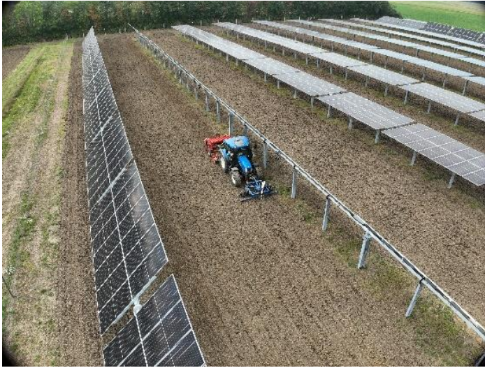
Billede 2. Agri-PV solcelleanlæg med 12 meters afstand mellem vipbare paneler (Foto: Tim Nellemann Bak).
