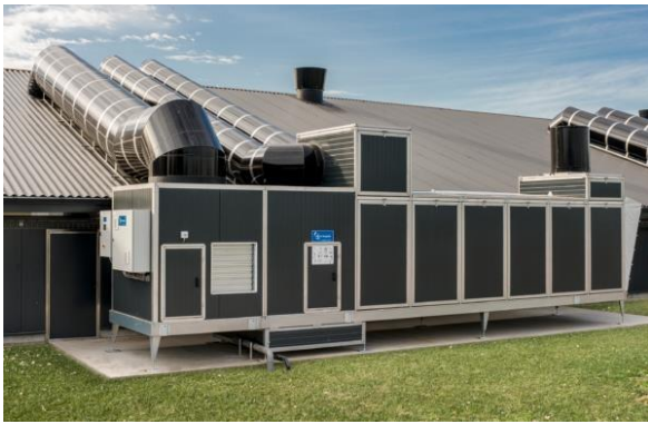
Figur 1. Billede af varmeveksler af typen Agro Clima+ fra Vencomatic og Rokkedahl Energi. Til venstre ses selve varmeveksleren indblæsnings- og udsugningsrør. Til højre ses en skitse, hvor man kan se selve varmevekslermodulet. (Foto: Rokkedahl Energi).
