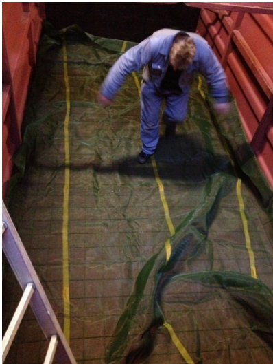
Figur 2 Rio-net og filternet på den hældende bund i containere for at lette dræning.
