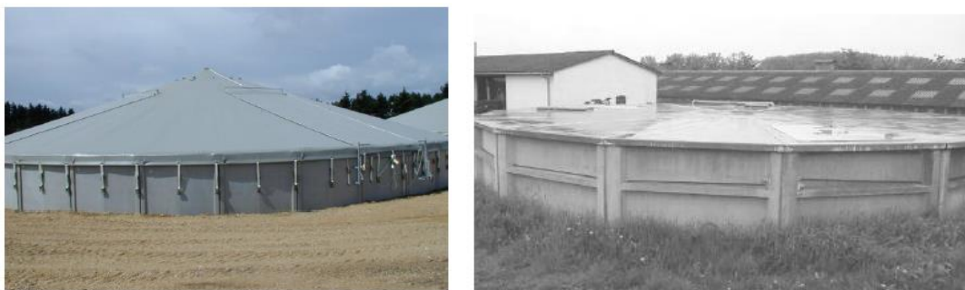
Figur 3. Eksisterende metoder til overdækning af gyllelagre, teltoverdækning og betonlåg.
